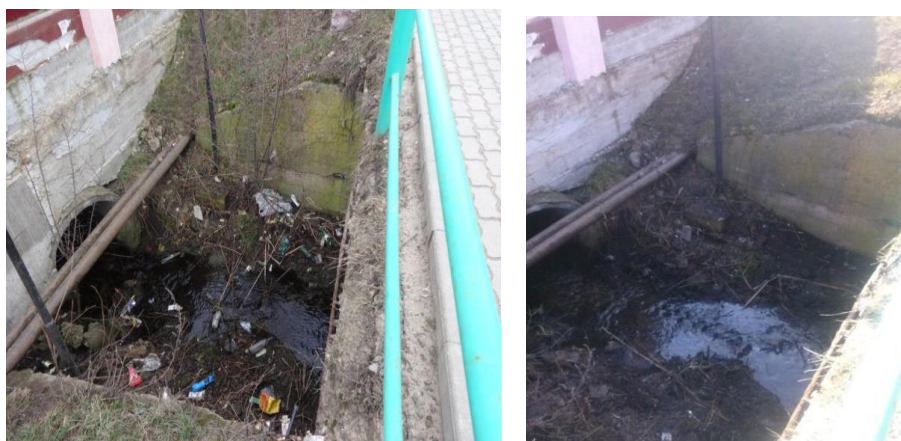
Ливневая канава по ул. Социалистической в г. Слуцке очищена от бытового мусора
